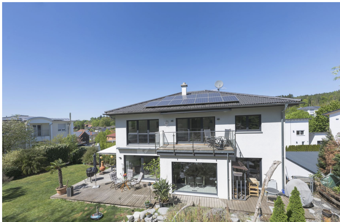
Rückfassade mit Balkon und Terrassenbereich
