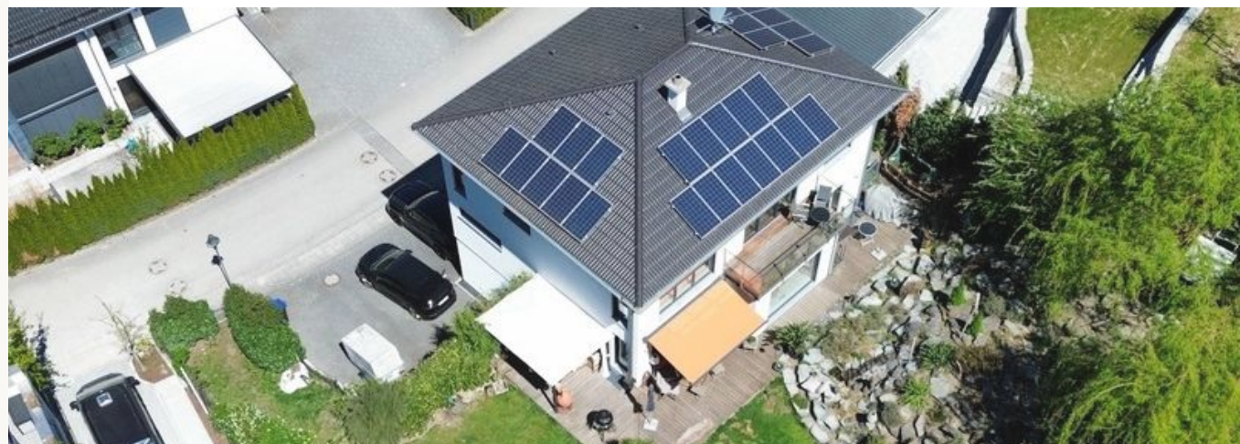
7,14-kWp-PV-Anlage (28 Module) auf dem Walmdach – Drohne
