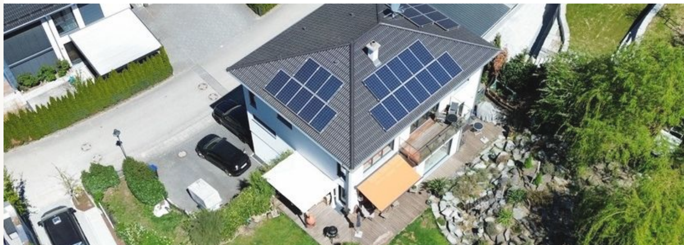
7,14-kWp-PV-Anlage (28 Module) auf dem Walmdach – Drohne
