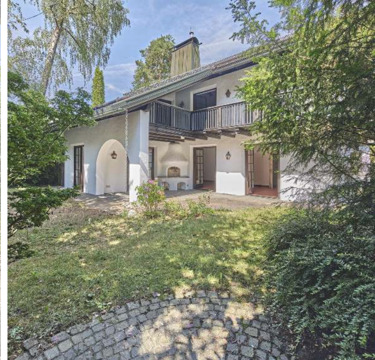
Südansicht mit Balkon und Terrasse
