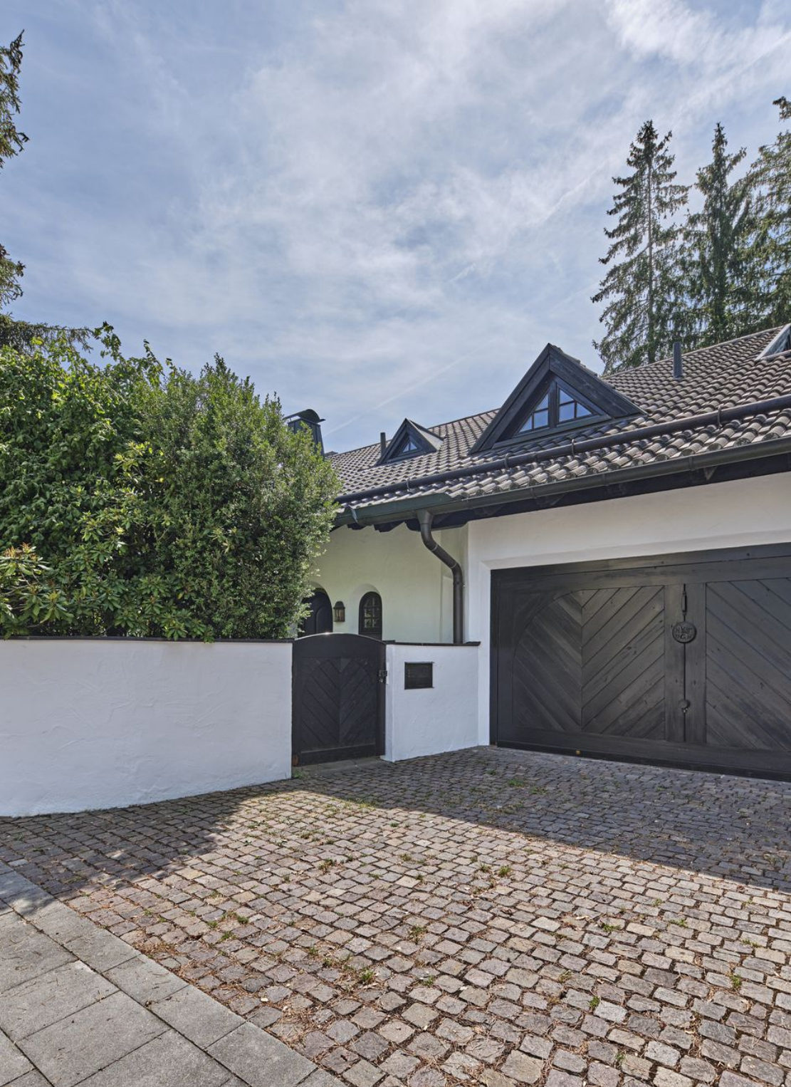
Hauptansicht mit Einfahrt und Doppelgarage
